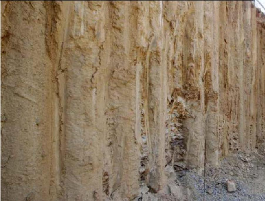
Após a escavação, cortina de contenção, com estacas de concreto armado impede o deslizamento do solo.
