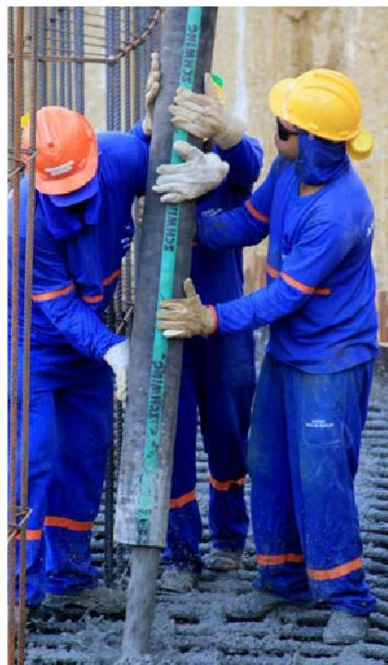
3 mil m<sup>3</sup> de concreto autoadensável, o equivalente a 320 caminhões carregados com a matéria-prima são aplicados pelos tubos de concretagem.
