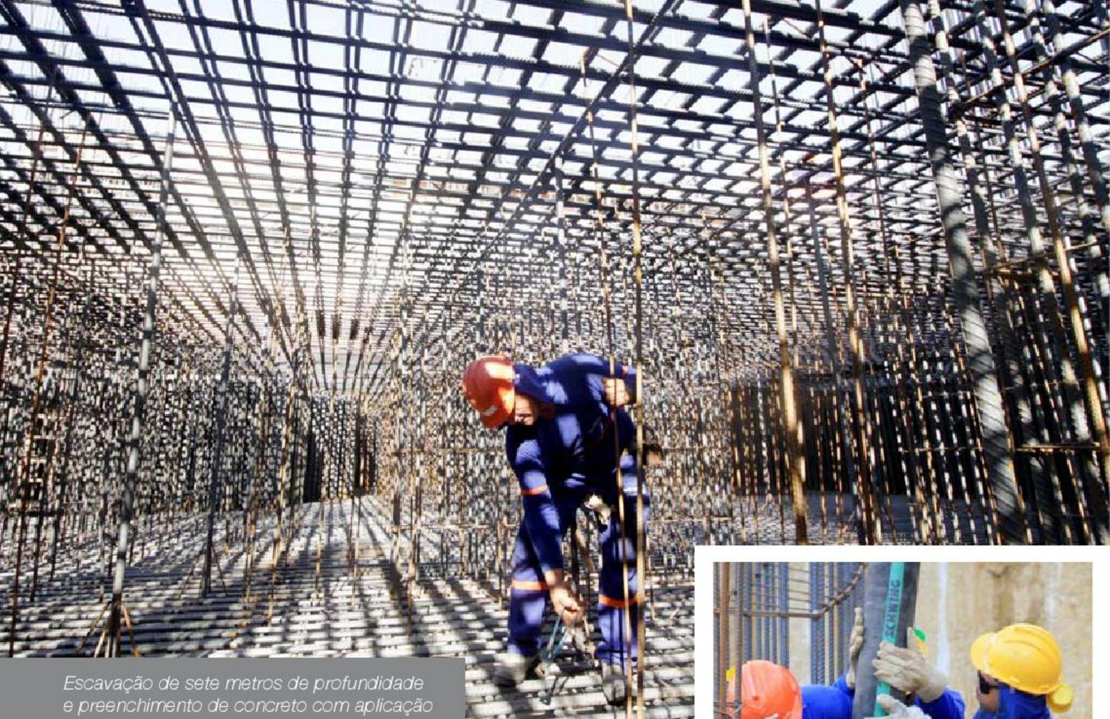
Escavação de sete metros de profundidade e preenchimento de concreto com aplicação da armadura de aço.
