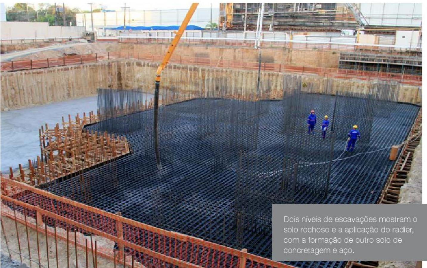
Dois níveis de escavações mostram o solo rochoso e a aplicação do radier, com a formação de outro solo de concretagem e aço.
